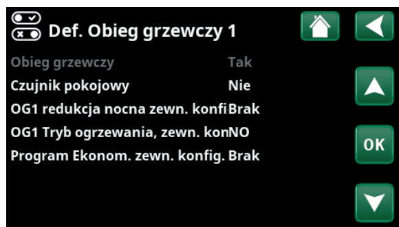
Menu „Instalator/Definiowanie/Obieg grzewczy/Obieg grzewczy 1”.
