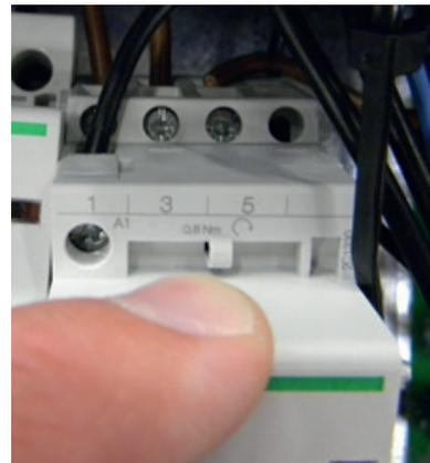
5. Montieren Sie die schwarzen Drähte an den freien Stellen der elektrischen Heizung.
