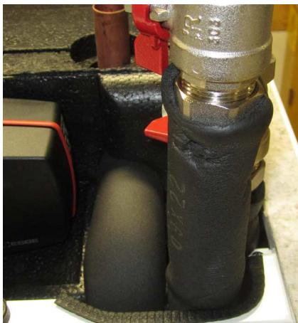
Fäst kantlisten för att undvika slitage på isoleringen.
