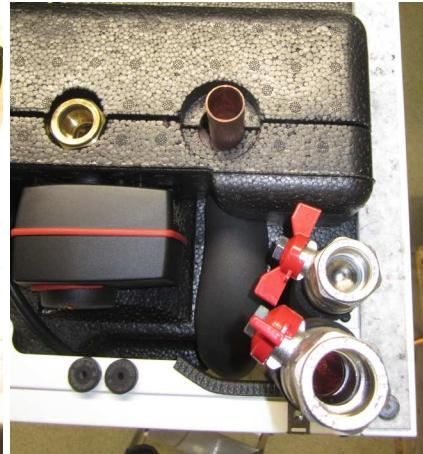
Fäst kantlisten för att undvika slitage på isoleringen.
