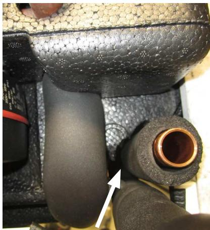
Skär i isoleringen för att få plats med röret.
