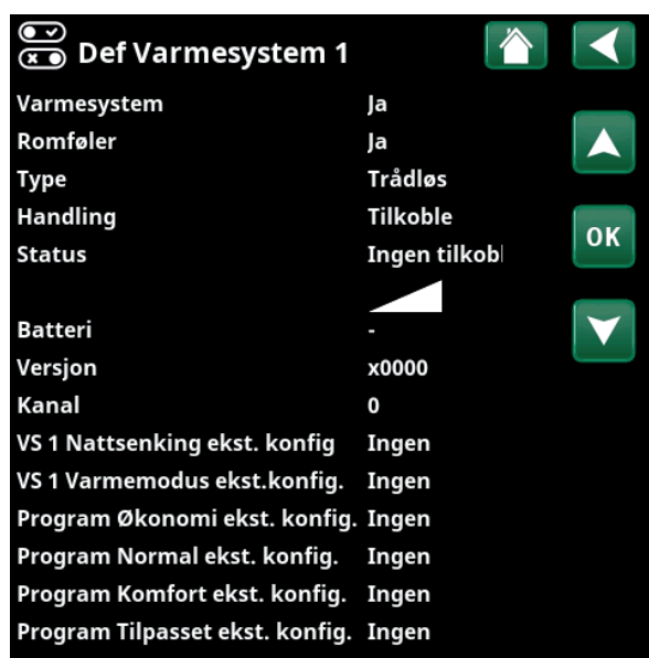
Meny «Avansert/Definere/Varmesystem/Varmesystem 1». Trådløs romføler er valgt.
