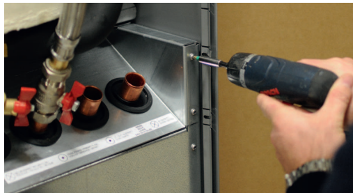
3. Skru kølemodulets skruer af.
