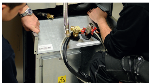
5. Dra ut kjølemodulen ved først å løfte fremkanten litt opp i bærehåndtakene.
