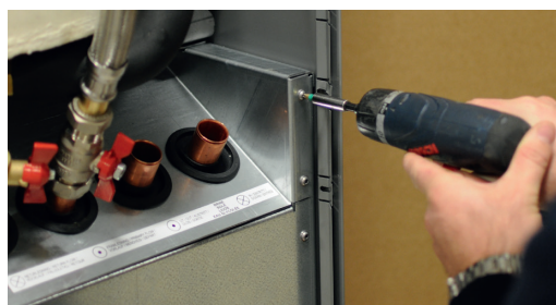
3. Skru ut kjølemodulens festeskruer.
