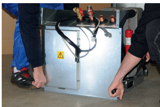
6. Løft kjølemodulen ved hjelp av bærehåndtakene og bæreremmene.
