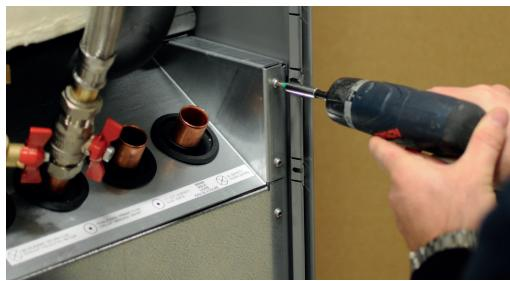
3. Draai de schroeven van de koelmodule los.
