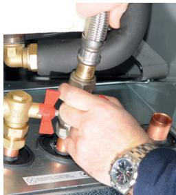
1. Koppel de connector van de voedingskabel en de slangen van de koelmodule los.
