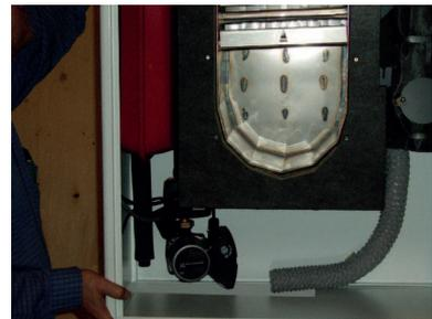
4. Wenn der Heizkessel positioniert ist, setzen Sie die Reinigungstür und den Brenner wieder ein. Befestigen Sie das Brennerkabel und den Zuluftanschluss Schlauch.
