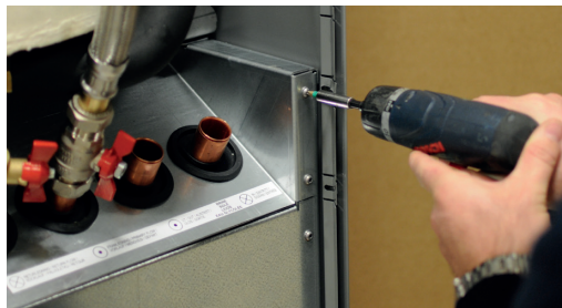
3. Poista kylmämoduulin kiinnitysruuvit.
