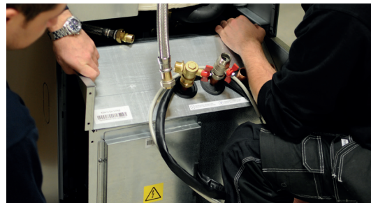
5. Vedä kylmämoduuli ulos ja nosta samalla hieman ylöspäin kahvoista.
