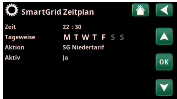
Die Funktion SmartGrid „SG Niedertarif“ ist für Wochentage zwischen 22:30 und 06:00 vorgesehen. Das Menü erscheint, wenn Sie im Menü „Fachmann/Einstellungen“ das „SmartGrid Zeitplan“ anwählen.
