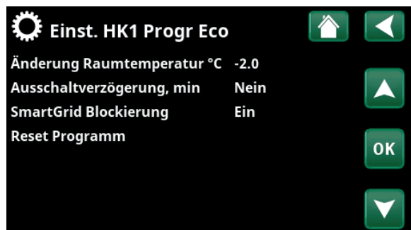
Menü „Fachmann/Einstellungen/Heizkreis/Heizkreis 1/Programm/Eco“.
