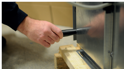
2. Fest de to bærehåndtakene i kjølemodulens nerkant.
