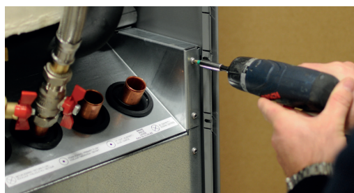
3. Skru ut kjølemodulens festeskruer.
