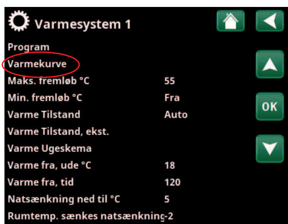
En del af menuen "Avanceret/Indstillinger/Varmesystem/Varmesystem 1".
