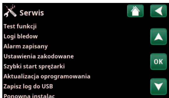
Menu: „Instalator/Serwis” (EZ i360).
