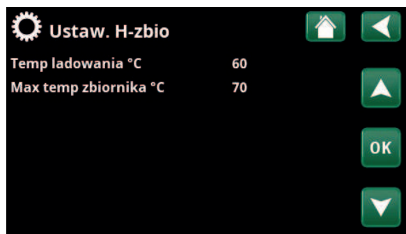
Menu: „Instalator/Ustawienia/Panele solar/H-Zbiornik”.
